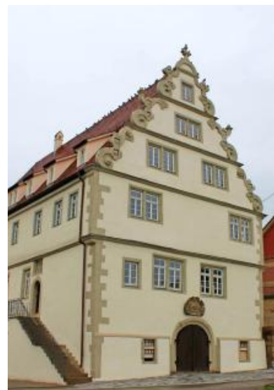
Nach der Sanierung bezieht die Verwaltung das Chanofsky-Schlössle.
