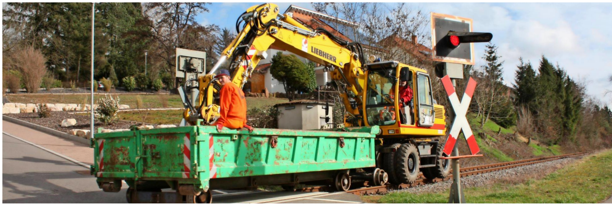
Ein ungewöhnliches Gespann auf den Gleisen: Zurzeit lässt die Erms-Neckar-Bahn AG als Eigentümerin der Strecke einige Stellen richten.
