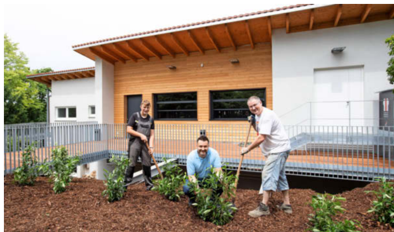
Vor der Einweihung am Freitag arbeiten die Macher der Freilichtspiele noch fleißig am Neubau (v.l.): Fabian Mayer, Andreas Großkopf und Michael Krämer. Foto: Veigel
