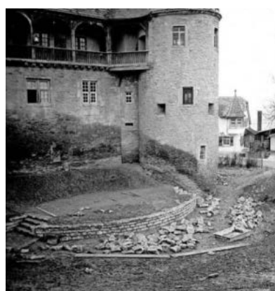
In vielen Arbeitsstunden wurde ein Bühnenrund aufgebaut.
